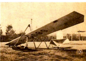
写真は初級グライダー練習機プライマリーで、文部省式I型機、このような機体が各中学校に配備されたのだ。
